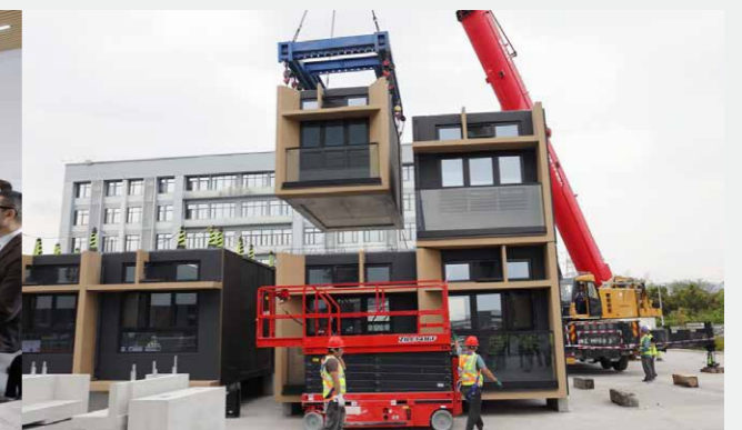
模組吊裝及安裝示範。
